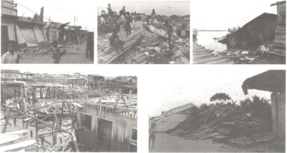
Fig. 9. Consecuencias del sismo y el tsunami del 12 de diciembre de 1979 en Tumaco. Fotos tomadas de Pararas-Carayannis (2000).
