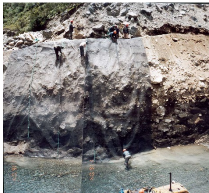
Fotografía 4. Geomallas biaxiales para disipación de caída de bloques.
