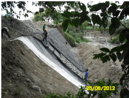
Fotografía 7. Protección de orillas con colchones de enrocado confiando con mallas poliméricas.
