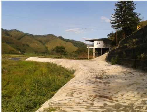
Fotografía 6. Protección de orillas con concreto utilizando formaletas textiles.
