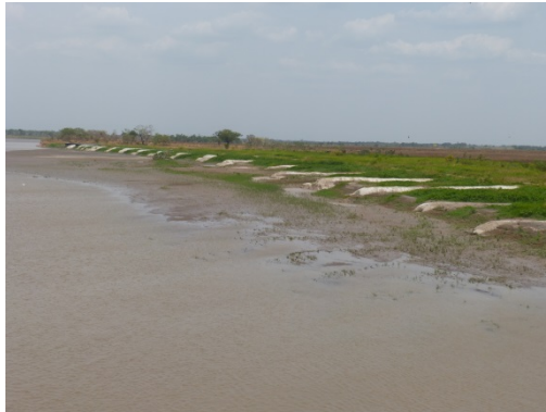
Fotografía 10. Espigones para encauzamiento conformados con tubos geotextil.
