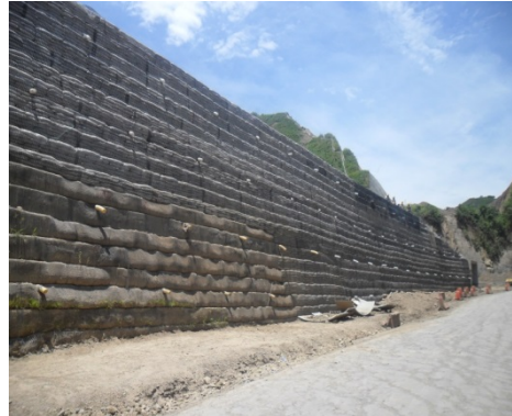
Fotografía 1. Estructura en suelo reforzado con geomallas.
