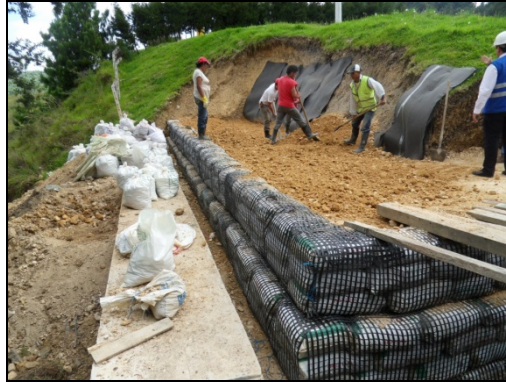
Fotografía 2. Construcción de estructura en suelo reforzado con geomallas.
