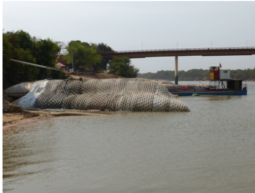
Fotografía 11. Revestimiento de tubos geotextil con formaletas textiles llenas con concreto.
