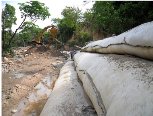
Fotografía 9. Tubos geotextiles para protección de orillas.
