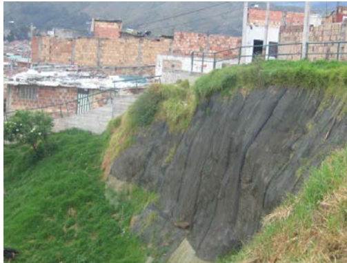
Fotografía 5. Geomallas biaxiales para control de caída de bloques.
