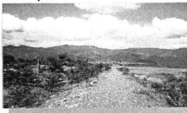
Las Malvinas: Dique que separa el asentamiento y el río Guatiquía
